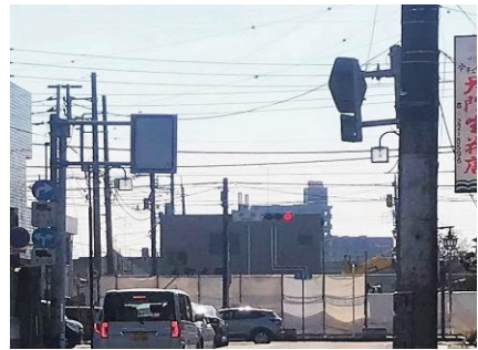
道路部分になる建物を解体
